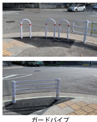
ガードパイプ
